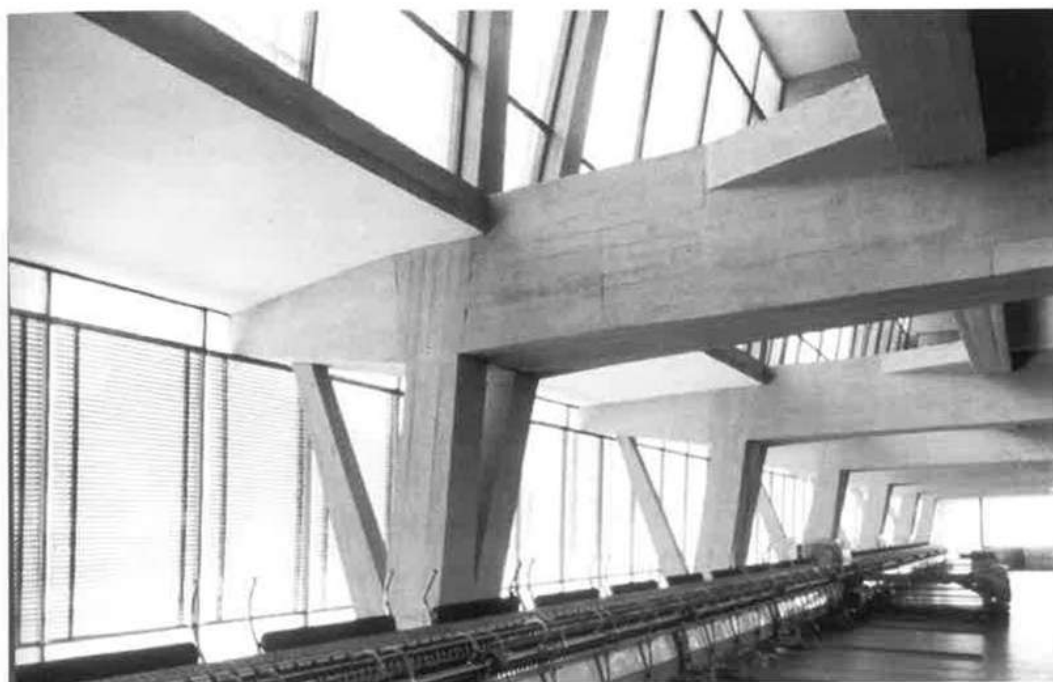
Capalle, Campi Bisenzio (Fi): stabilimento della Manifattura Goti, 1959-1961, particolare delle strutture. Progetto L. Ricci (fotografia di G. Gameliet)
