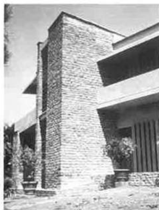
Poggio Gherardo, Setignano (Fi): Casa Fattiroli, 1954-1956, fronte principale e particolare (in basso). Progetto L. Ricci (fotografie di G. Gameliet, in alto, e di A. Garofalo, in basso)
